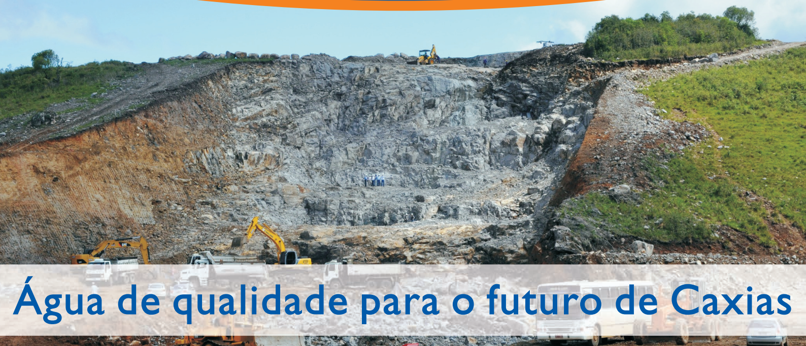
Obras na barragem
