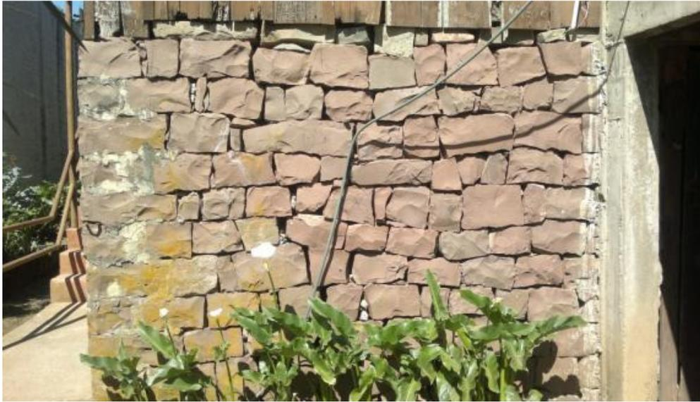
**FIGURA 29:** : Parede de pedra irregular do porão.
