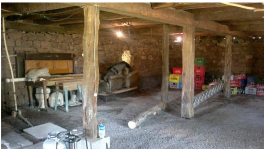
**FIGURA 30:** Disposição dos pilares no porão.
