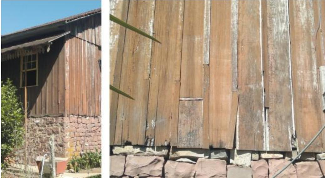
**FIGURA 36:** Fechamento externo da fachada lateral e fundos.
