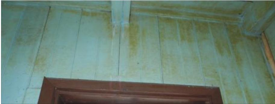
**FIGURA 34:** Fechamento interno com tabuas encaixadas com macho-e-fêmea.
