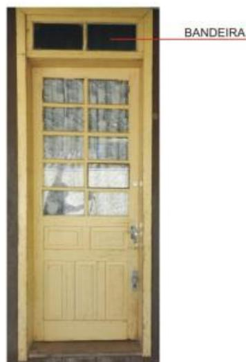
**FIGURA 48:** Porta externa de uma folha na fachada lateral.
