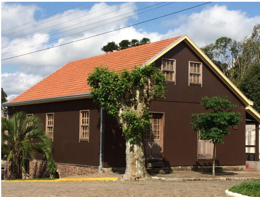
Figura 19 - Colocação das aberturas e pintura
