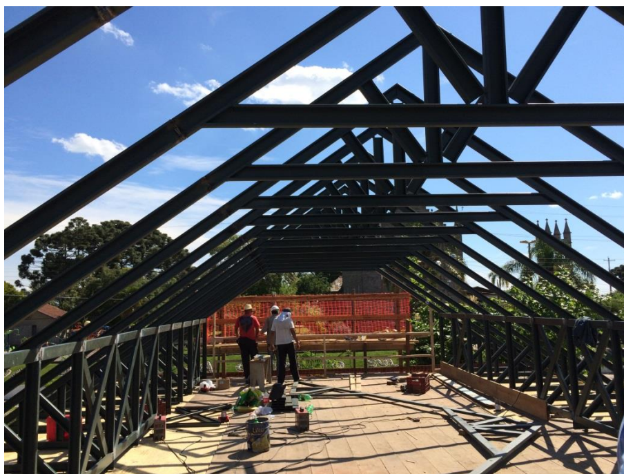
Figura 11 – Substituição das tabuas e montagem da estrutura metálica
