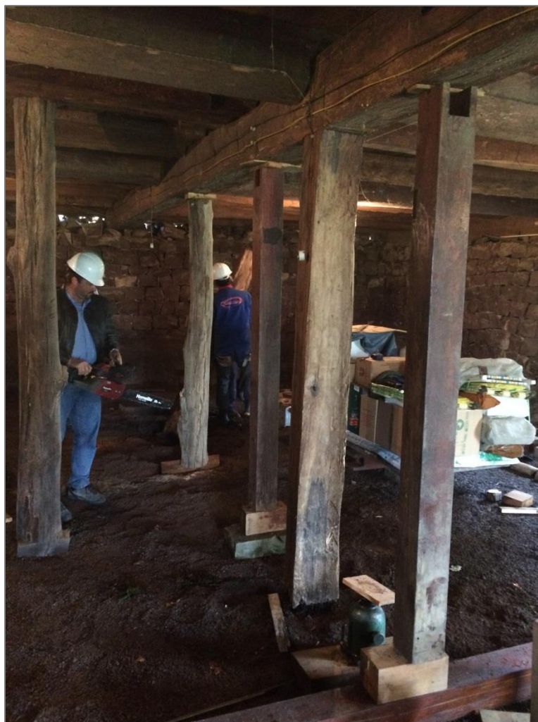
Figura 1 – Escoramentos para retirada dos pilares
