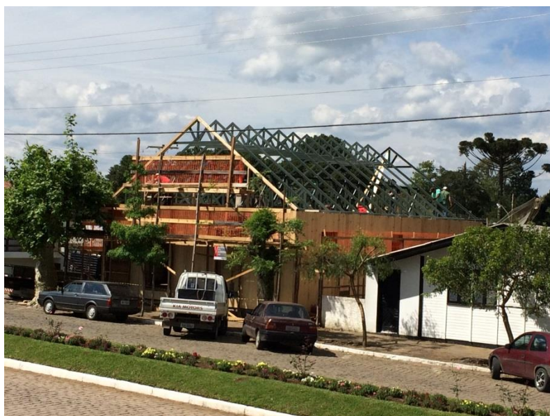
Figura 12 - Substituição das tabuas e montagem da estrutura metálica
