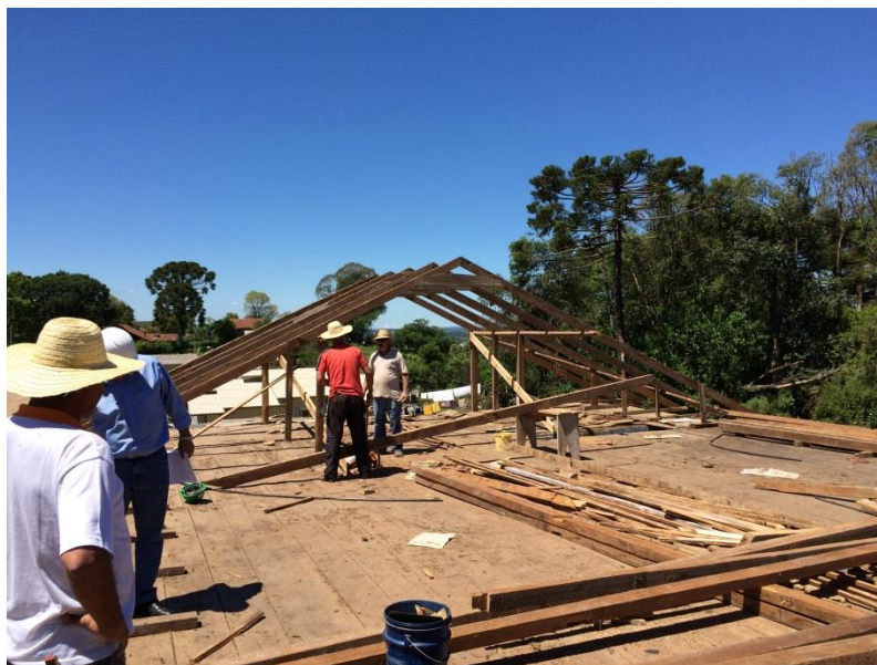
Figura 9 - Remoção de telhas e estrutura de madeira da cobertura
