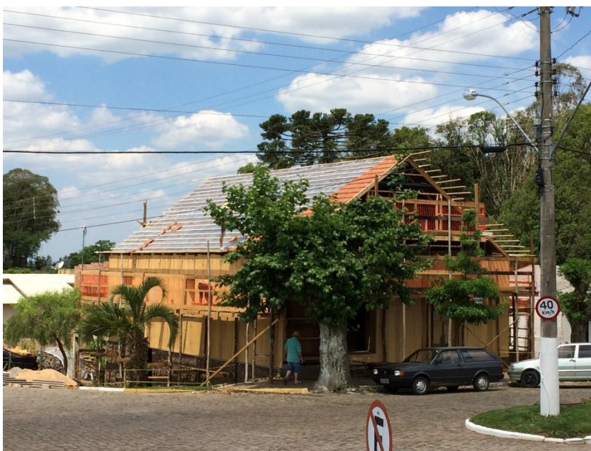
Figura 14 - Manta térmica e novas telhas
