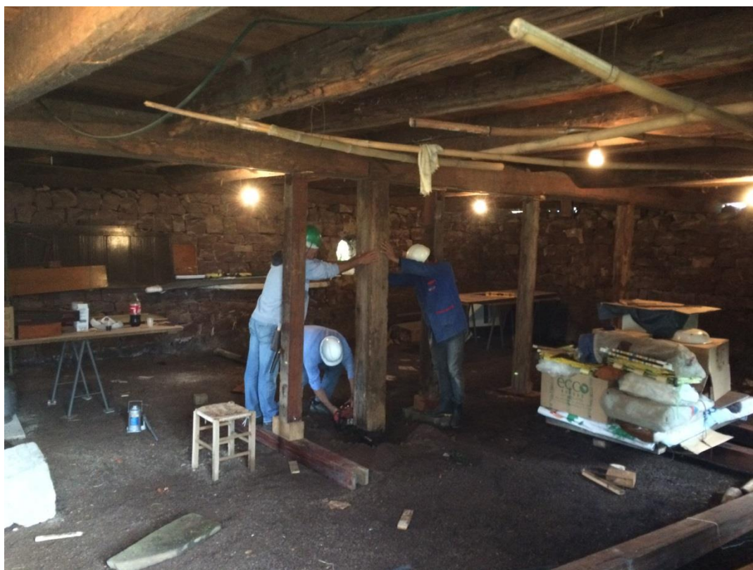
Figura 2 – Remoção dos pilares existentes
