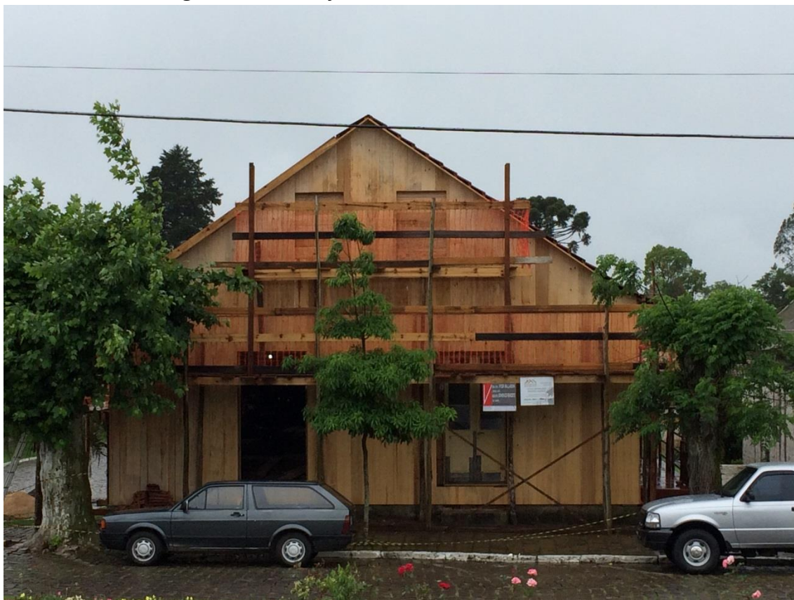
Figura 15 - Execução dos oitão e beirais da cobertura
