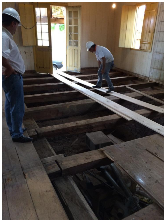
Figura 18 - Substituição das tabuas degradadas do assoalho do piso térreo
