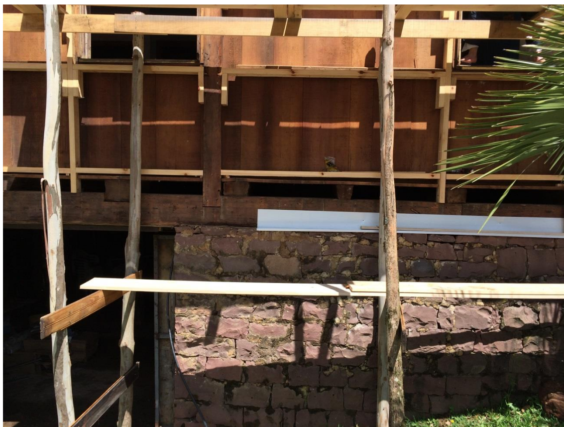
Figura 7 – Fixação da algerosa galvanizada
