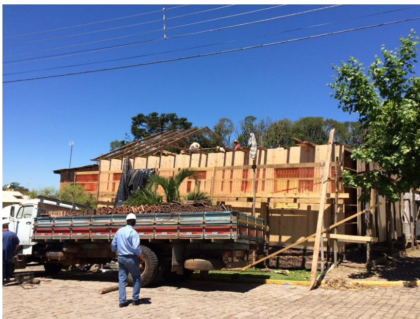
Figura 10 - Remoção de telhas e estrutura de madeira da cobertura
