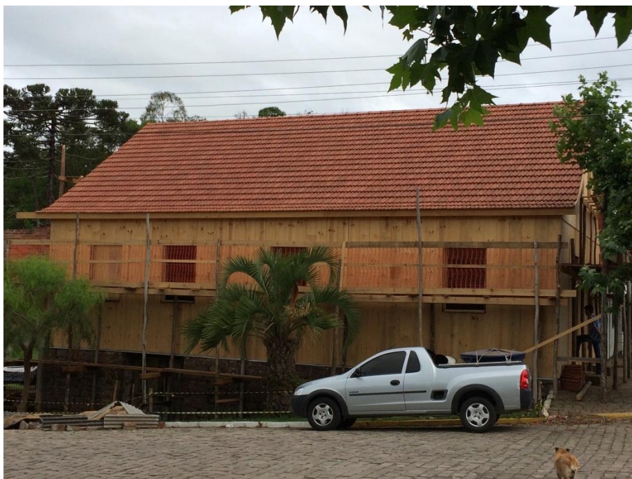
Figura 17 - Execução dos oitão e beirais da cobertura
