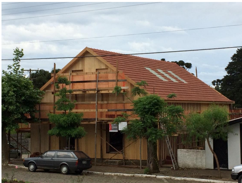
Figura 16 - Execução dos oitão e beirais da cobertura
