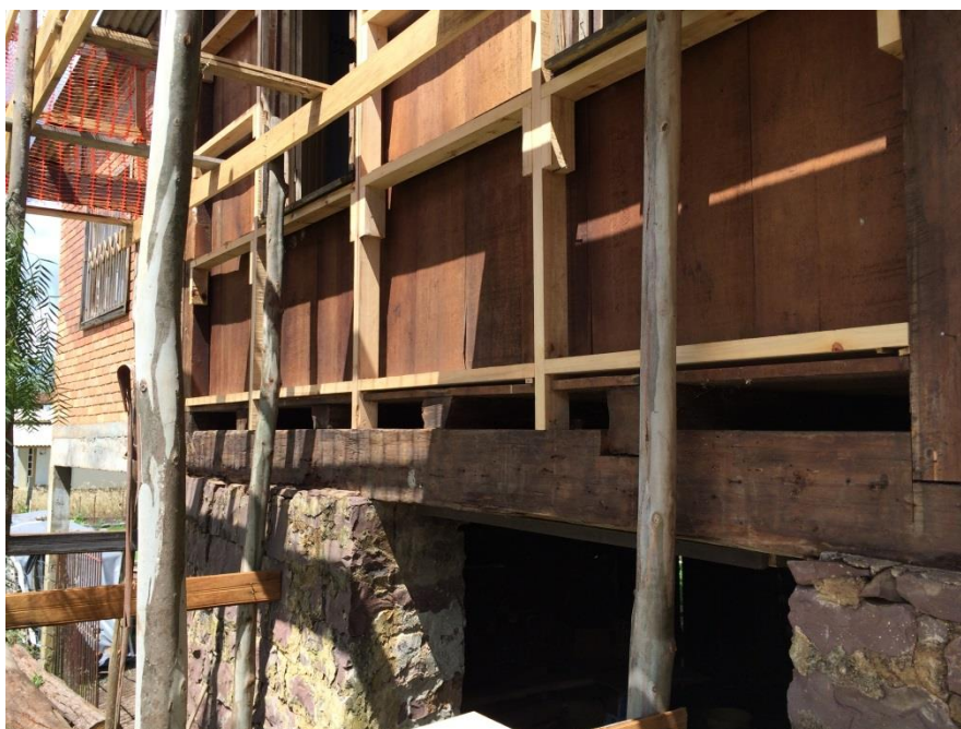
Figura 6 - Substituição de tabuas nas fachadas
