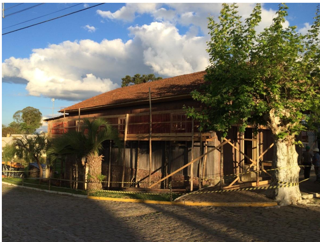
Figura 4 - Construção de andaimes e guarda-corpos de madeira
