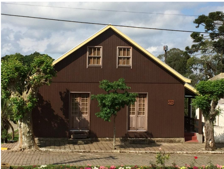
Figura 20 - Colocação das aberturas e pintura
