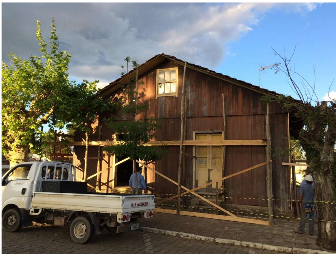
Figura 3 - Construção de andaimes e guarda-corpos de madeira
