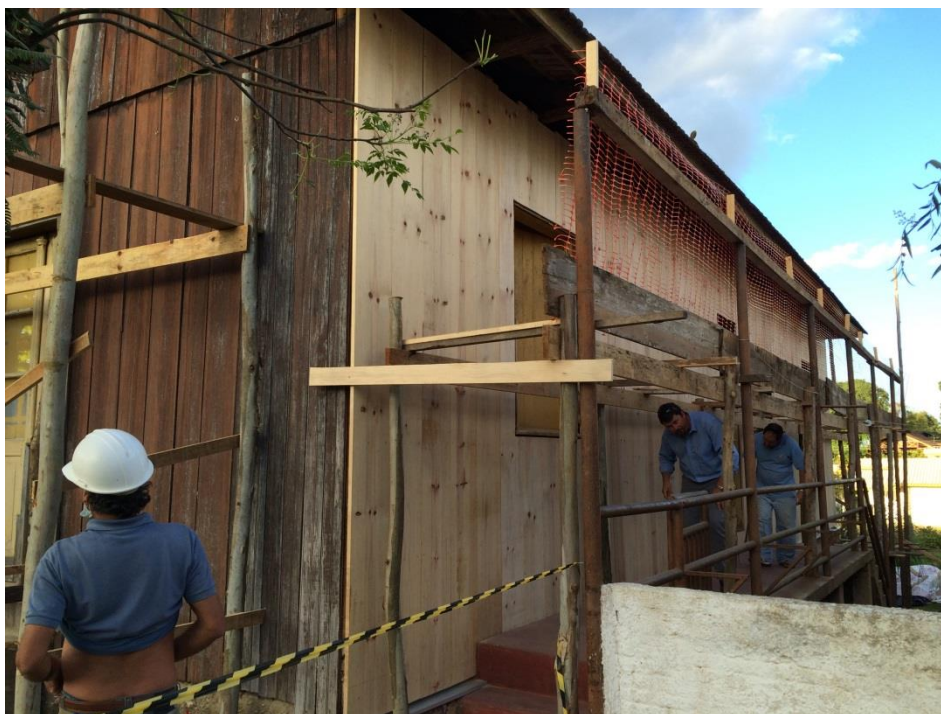
Figura 5 – Substituição de tabuas nas fachadas
