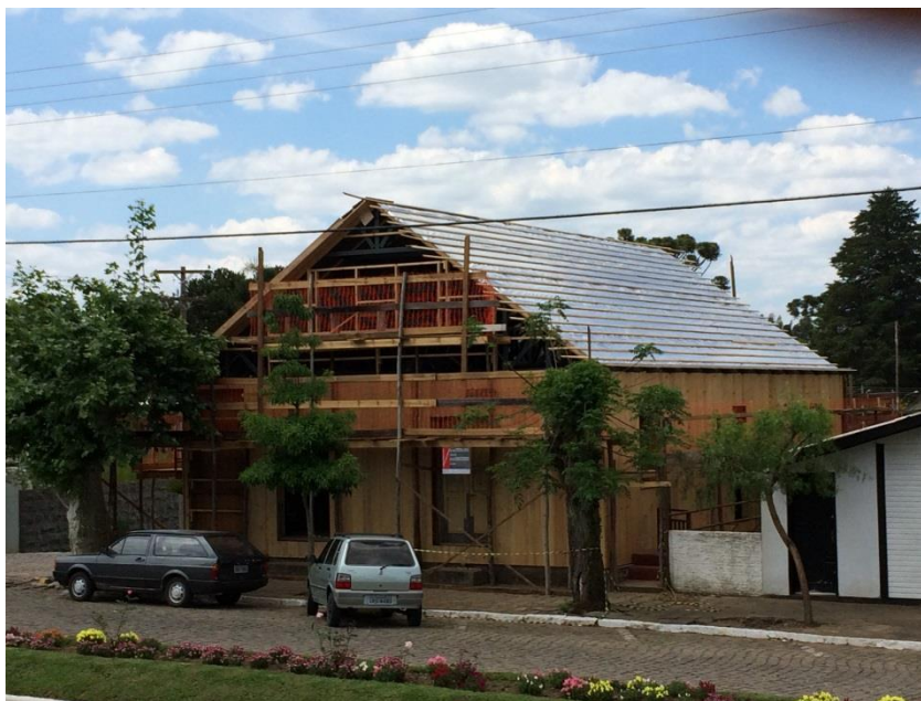
Figura 13 – Manta térmica e novas telhas
