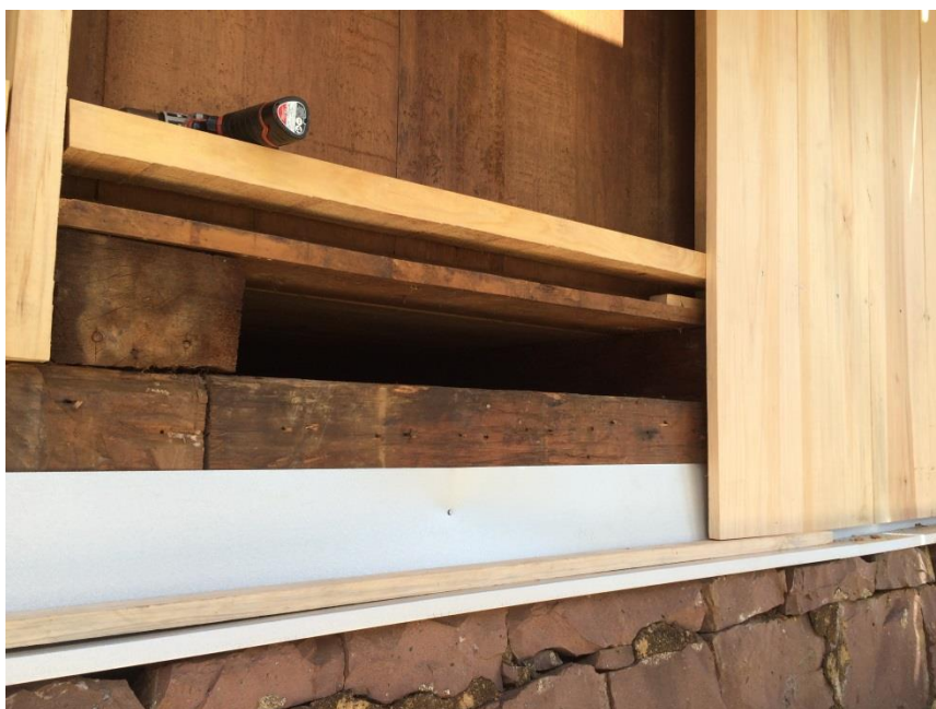
Figura 8 – Fixação da algerosa galvanizada
