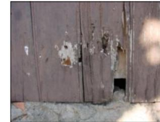
02: DEGRADAÇÃO DA MADEIRA DO FECHAMENTO POR ATAQUE DE INSETOS XILÓFAGOS E CONCENTRAÇÃO DE UMIDADE
