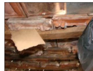
01: INFILTRAÇÕES GENERALIZADAS DAS TELHAS PROPICIAM A AÇÃO DA UMIDADE SOBRE AS ESTRUTURAS DE MADEIRA DO TELHADO, COMPROMETENDO SUA FUNÇÃO
