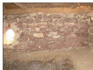
05: FISSURAS NA ALVENARIA DE PEDRA IRREGULAR SUGERINDO UMA ACOMODAÇÃO DE FUNDAÇÃO.
