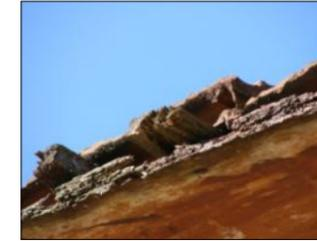
01: DEGRADAÇÃO DAS PEÇAS DO BEIRAL EM FUNÇÃO DA UMIDADE CONCENTRADA
