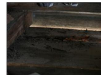
01: PISO DE MADEIRA DO SÓTÃO TOTALMENTE DEGRADADO PELA INFILTRAÇÃO DO TELHADO
