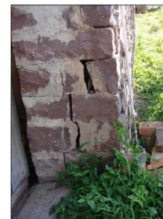
05: FISSURAS NA ALVENARIA DE PEDRA IRREGULAR SUGERINDO UMA ACOMODAÇÃO DE FUNDAÇÃO.
