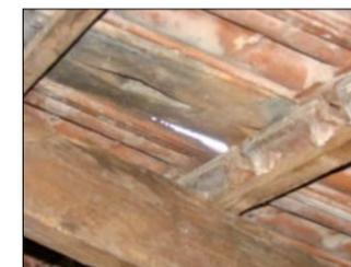
02: TELHAS DA COBERTURA APRESENTAM DIVERSOS PADRÕES DE DIMENSÃO E DE ENCAIXE, O QUE GERA PROBLEMAS DE ASSENTAMENTO DAS PEÇAS, COMPROMETENDO A ESTANQUEIDADE DO TELHADO.
