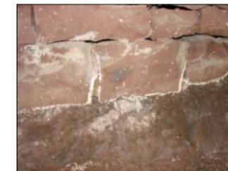
02: INFILTRAÇÕES DE ÁGUAS PLUVIAIS NAS LINHAS DAS PAREDES DE PEDRA, INCLUSIVE APRESENTANDO CARBONATAÇÃO
