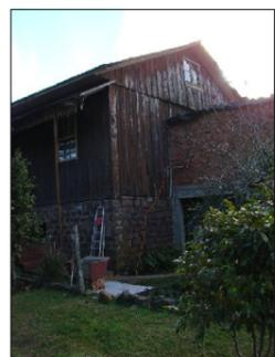
01: DEGRADAÇÃO DA MADEIRA DO FECHAMENTO POR ATAQUE DE INSETOS XILÓFAGOS. JUNÇÃO DO VOLUME ANEXO DE ALVENARIA COM O CORPO PRINCIPAL DE MADEIRA APRESENTA INFILTRAÇÃO
