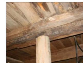
04: ATAQUE DE INSETOS XILÓFAGOS NAS PEÇAS ESTRUTURAIS DE MADEIRA COM A INCIDÊNCIA DE UMIDADE DESCENDENTE, O QUE PROVOCOU A RUINA DA PEÇA E A NECESSIDADE DE ESCORAMENTO SUPLEMENTAR
