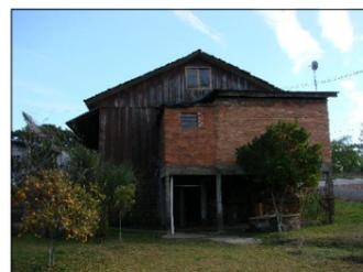
01: DEGRADAÇÃO GENERALIZADA DA MADEIRA E UMIDADE CONCENTRADA NO TELHADO DO VOLUME ANEXO DE ALVENARIA
