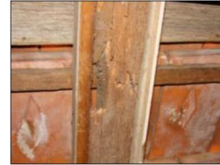
01: ESTRUTURA DO TESOURAMENTO EM MADEIRA COM RUPTURAS AO DESGATES DO TEMPO, UMIDADE E INSETOS XILÓFAGOS
