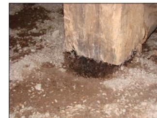
05: UMIDADE ASCENDENTE DO PISO AFETANDO A INTEGRIDADE DOS ELEMENTOS DE MADEIRA
