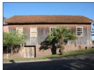
02: MADEIRA LEVEMENTE DEGRADADA POR CONCENTRAÇÃO DE UMIDADE ASCENDENTE. ESTE FECHAMENTO NÃO É O ORIGINAL.
