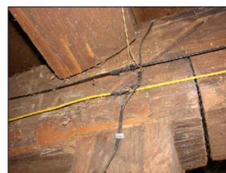
03: INSTALAÇÕES ELÉTRICAS PRECÁRIAS, COLOCANDO A EDIFICAÇÃO EM EVIDENTE RISCO DE SINISTROS.
