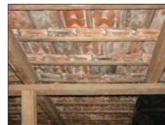
03: ESTRUTURA DE MADEIRA DO TELHADO ESTÁ COM SÉRIO COMPROMETIMENTO DE SUA FUNÇÃO PORTANTE EM CONSEQUÊNCIA DA AÇÃO DA UMIDADE.
